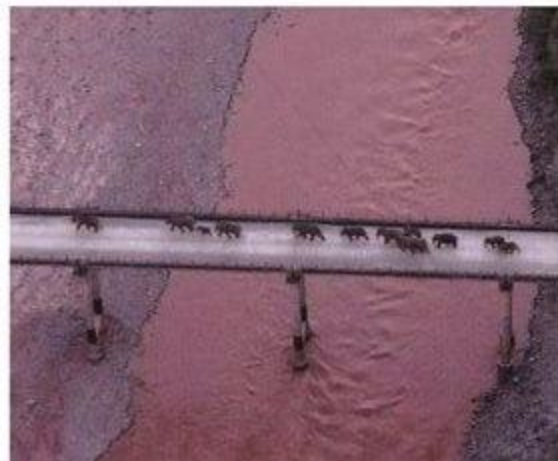
打探村 象群整齐地通过元江大桥
