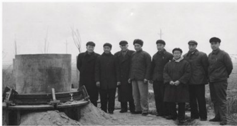
1961年在北京锅炉厂做锅炉爆炸封头成形试验（左六郑哲敏）
